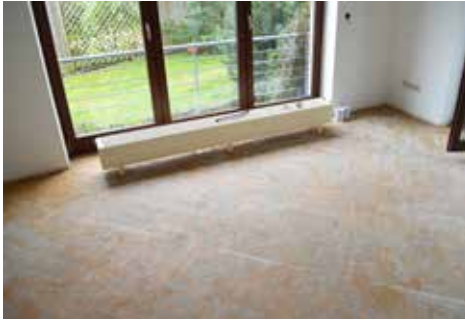
Entfernung der vorhandenen Oberbeläge und Heizkörper (bauseitig)
