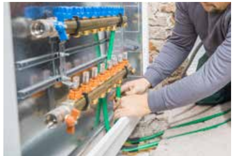
Anschluss der Fußbodenheizungsrohre an den Verteiler, Befüllung der Anlage mit Wasser und Dichtheitsprüfung
